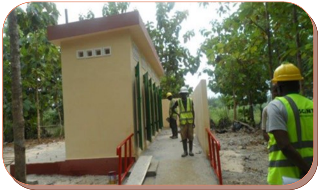
Le bloc de latrines terminé
