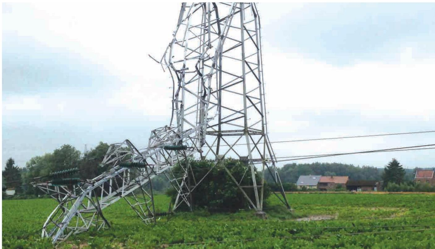
Les vents violents provoquent des effets de torsion tels que la tête du pylône est rompue.
